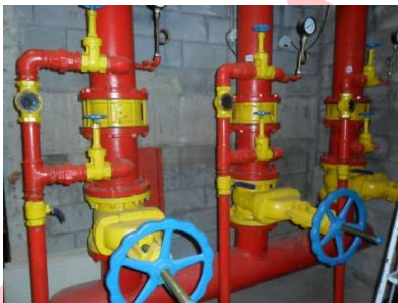
FIG 21.9 Válvula de governo e alarme – Fonte Internet
